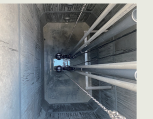
中継ポンプ槽設置例
