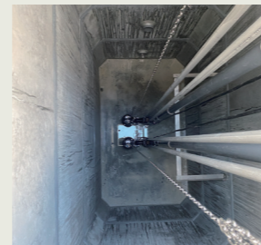
中継ポンプ槽設置例
