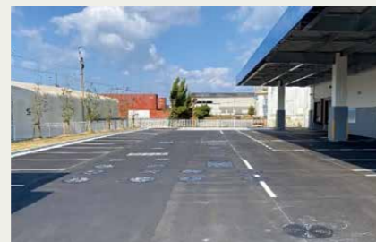
埋設式・上部駐車場
